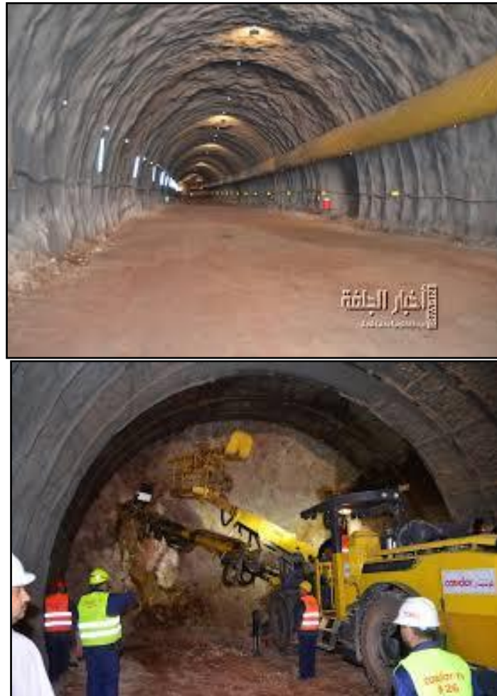
Figure 6. Travaux de creusement.
