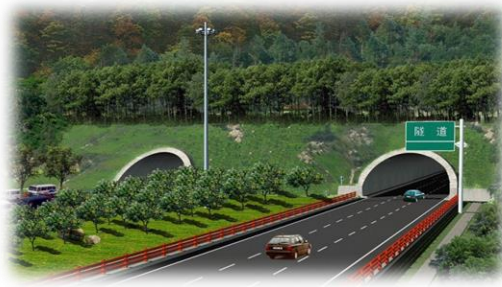
Figure 2. Réalisation d'un Tronçon Autoroutier sur 53 km
