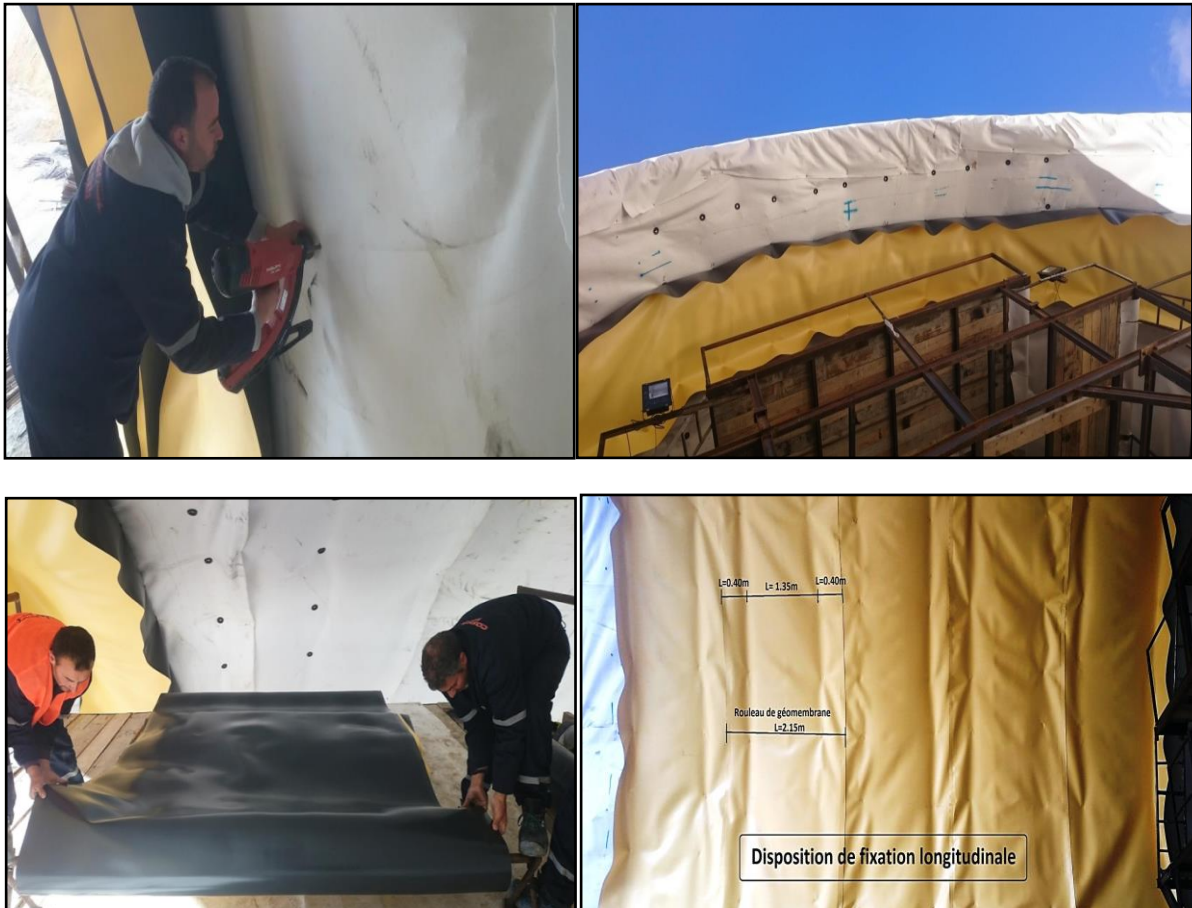
Figure 11. Mise en place de la géomembrane
