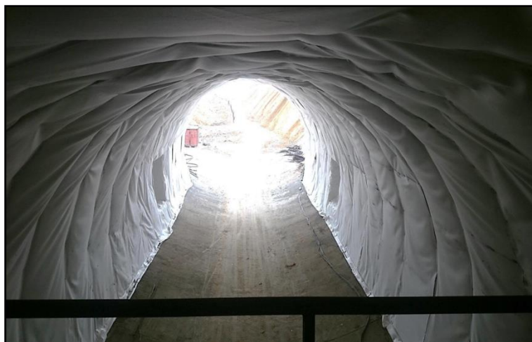
Figure 9. Fin de l'Opération de pose du géotextile
